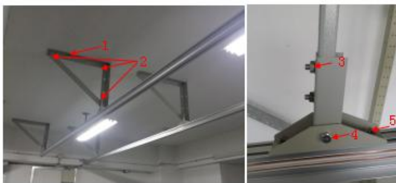
图六 吊装支架、轨道固定图
