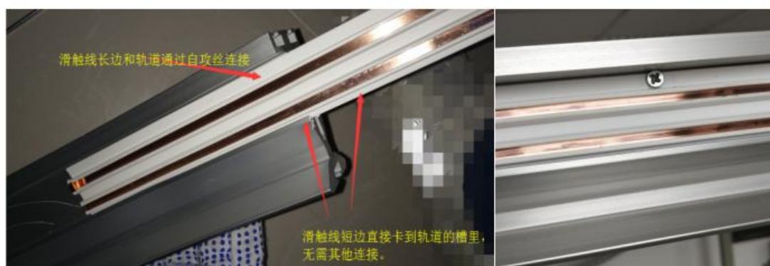
图八 滑触线安装图
